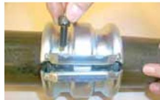
**步骤10**—将两片TUF-LOK金属盖罩放置在焊接环上，盖罩要平稳地紧固。
