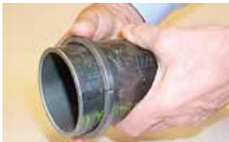
**步骤1**—将TUF-LOK连接卡环安装在整齐无毛刺的管道末端。
