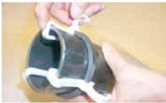
**步骤2**—用所提供的尼龙卡固定住TUF-LOK连接卡环，保证正确的焊接位置。
