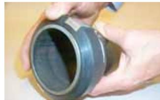
**步骤6**—TUF-LOK胶垫置于管道末端一侧。
