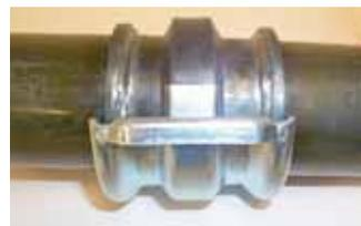
**步骤9**—把用于TUF-LOK垫圈上的金属衬套放置在盖罩之间。
